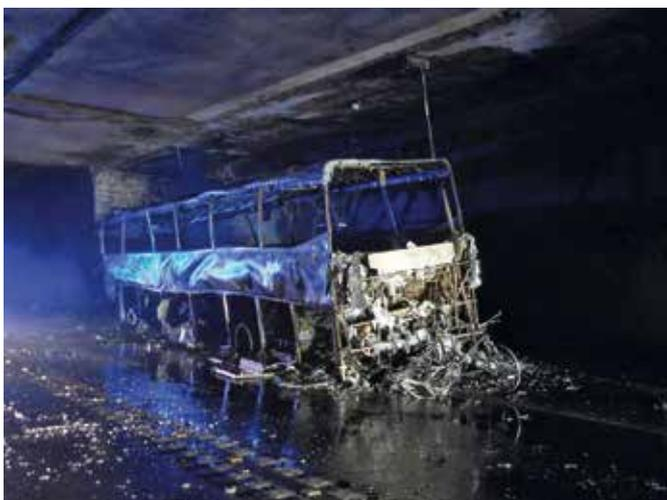
Busbrand gelöscht - weiterkühlen der beschädigten Tunneldecke
